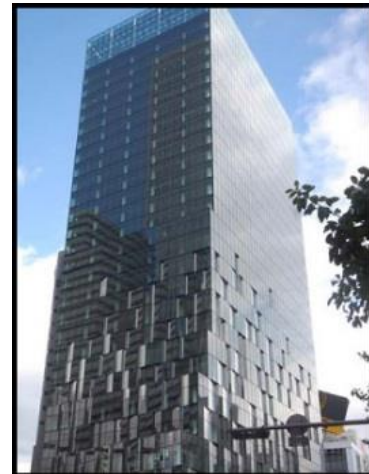
大阪富国生命ビル
